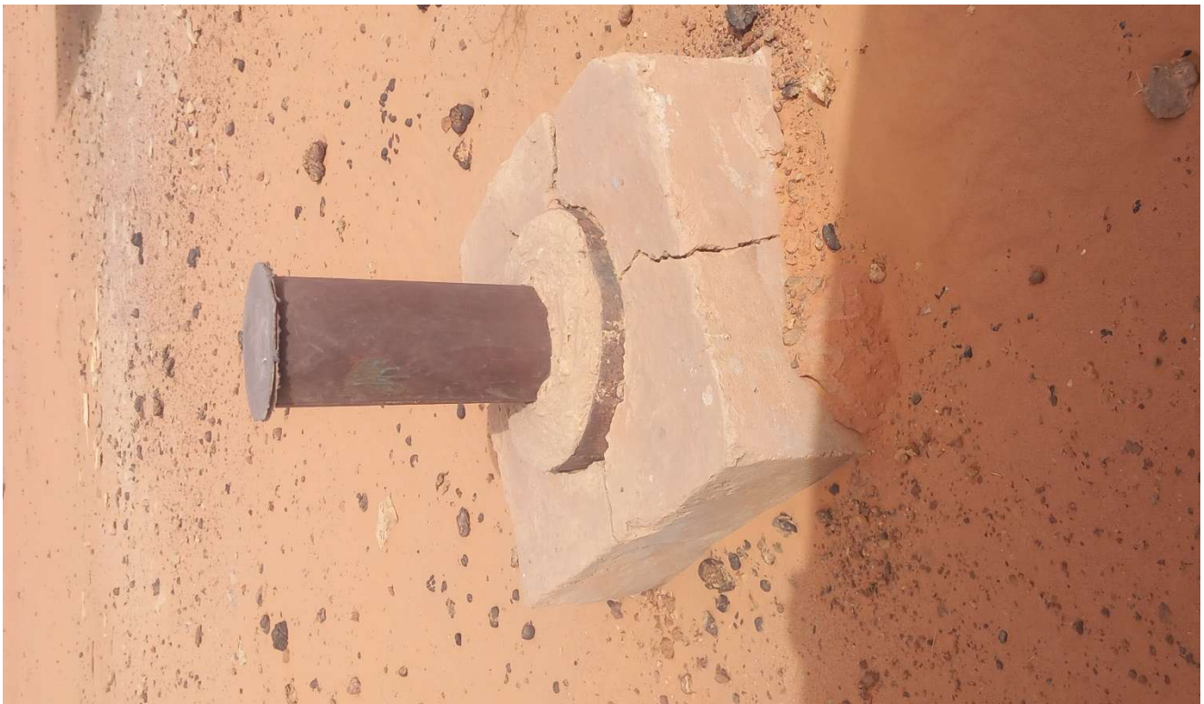
Forage à faible débit (Kdhoura) sera récupéré pour servir comme un piézomètres
